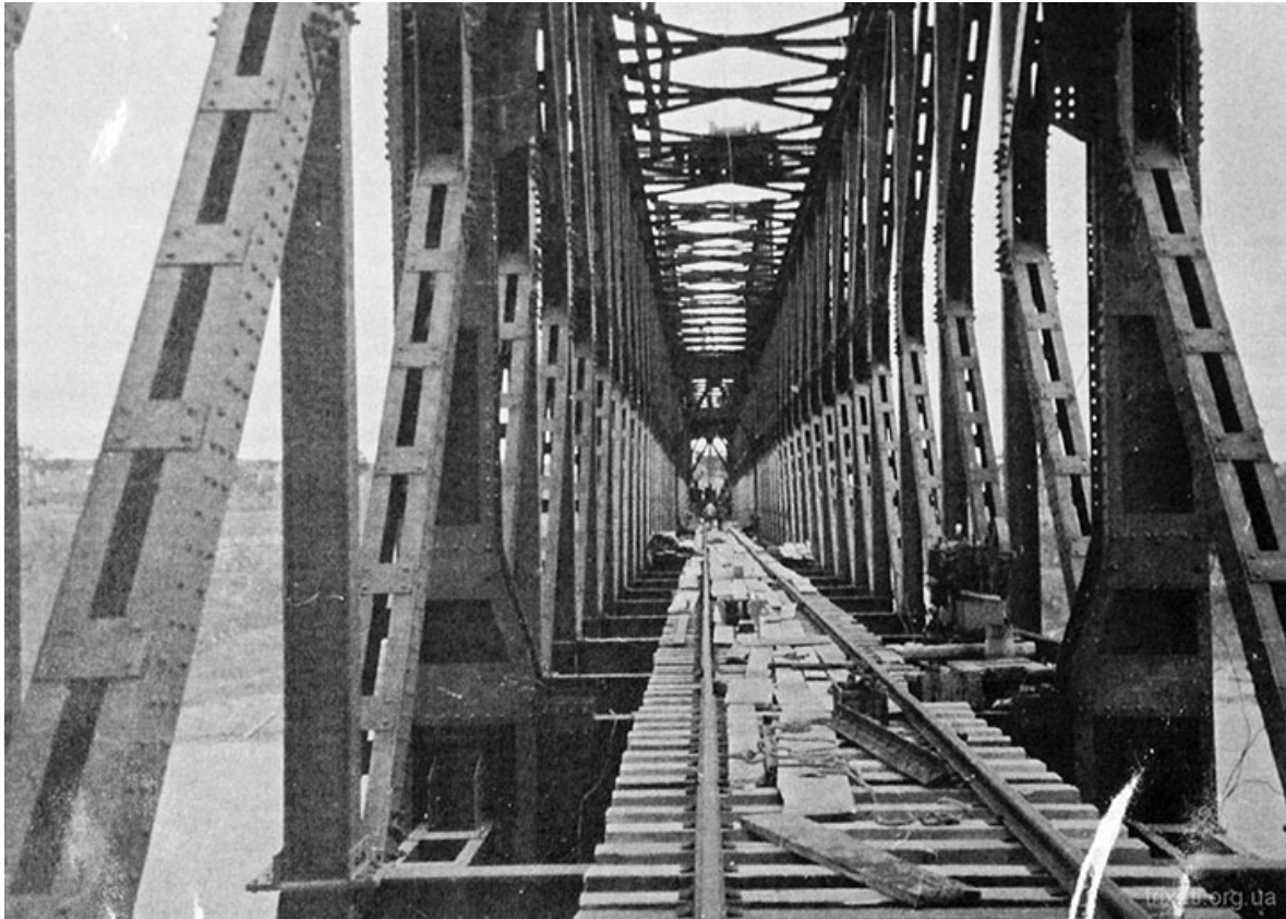
Вид зібраної ділянки мосту. На передньому плані – отвір для можливості піднімання частин мосту, які привозили на човнах
