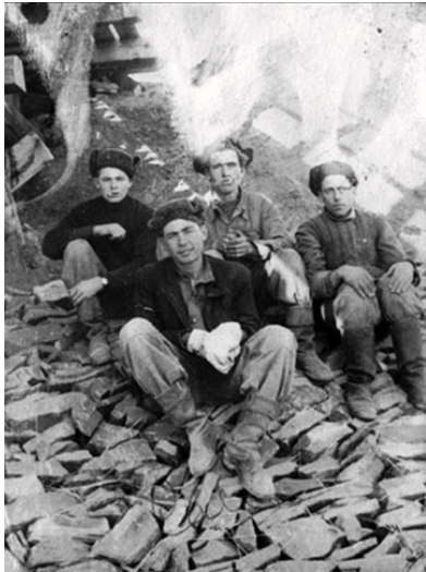
Мостобудівельники- жителі села, 1954 рік
