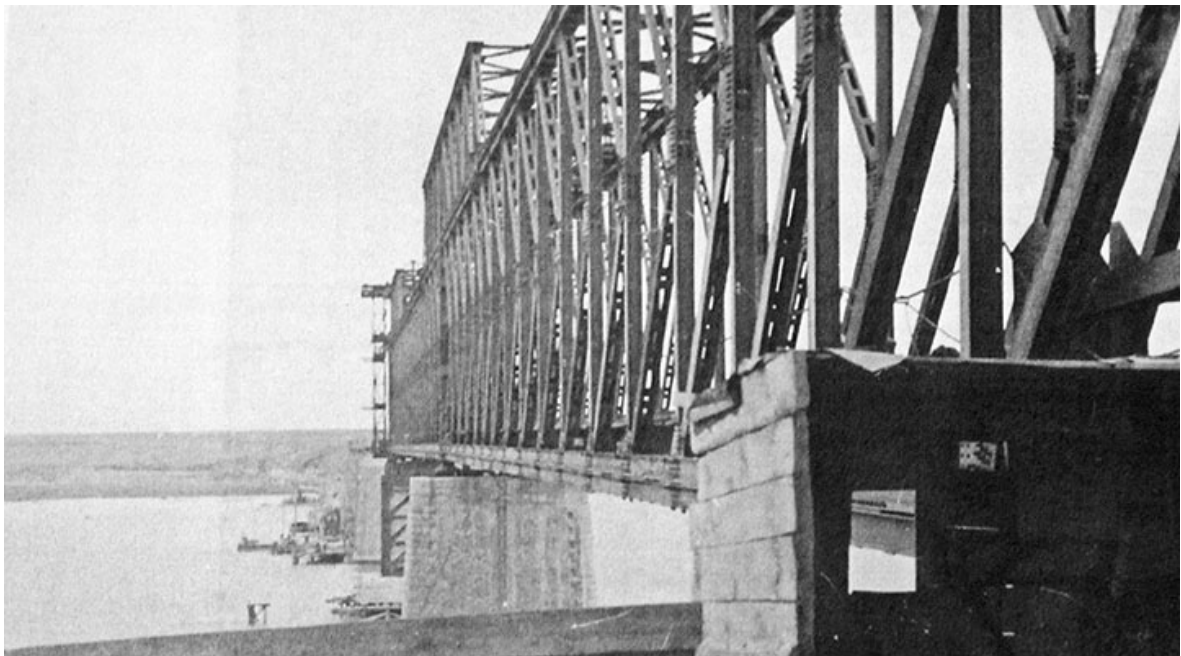
Вид повністю зібраної ділянки мосту
